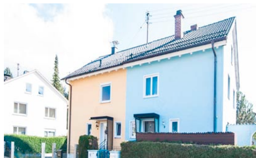
DOPPELHÄUSER ABB. 05 - 06 NANSENSTRASSE ABB. 07 BEETHOVENSTRASSE ABB. 08 SCHEIBENSTRASSE (O.LINKS NACH U.RECHTS)
