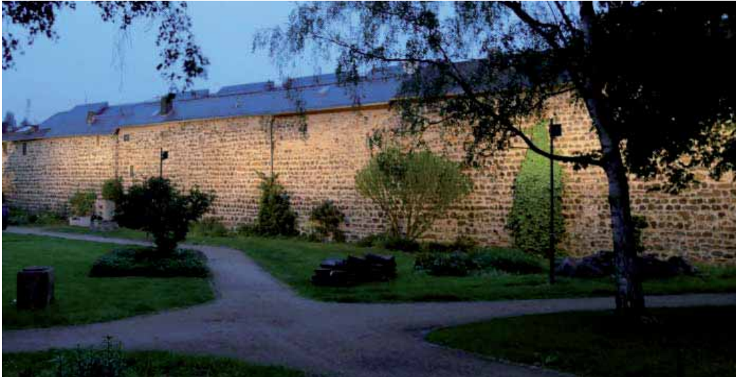
Referenzbild Anstrahlung Stadtmauer über mastmontierte Strahler / Stadtmauer Montabaur / Quelle: Irs
