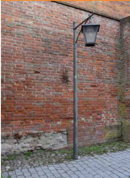
Mastleuchten mit angehängtem Leuchtenkopf / Parkbereich Am Einlaß
