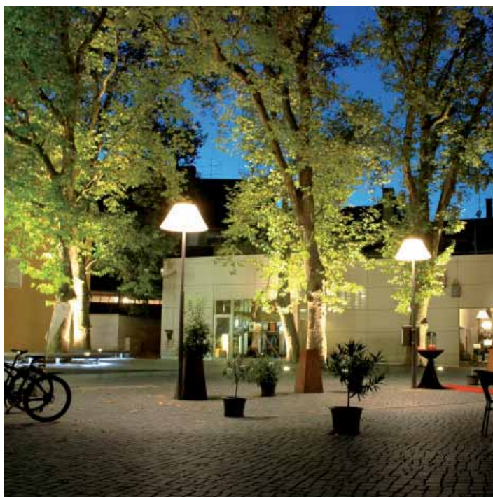
Elsbethenhof: Baumunterleuchtung und dekorative Platzleuchte / Quelle: Irs
