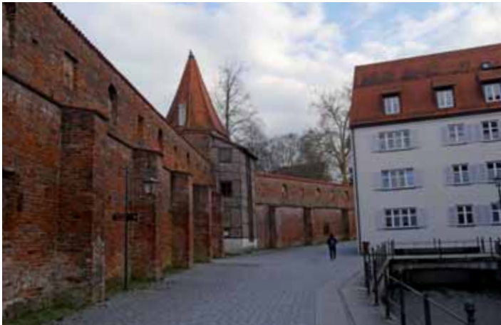
Am Einlaß: Ansicht Stadtmauer von innerhalb der Stadt / Quelle: Irs
